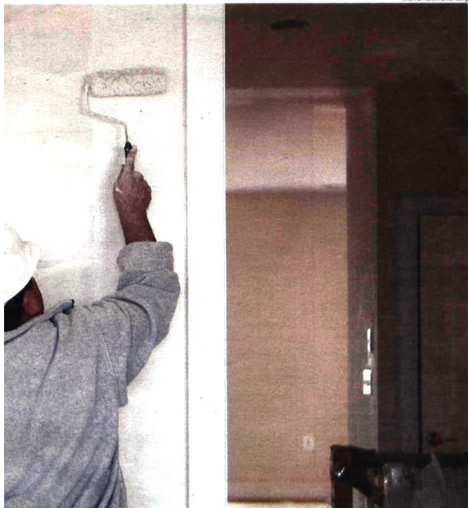
As obras de manutenção.
